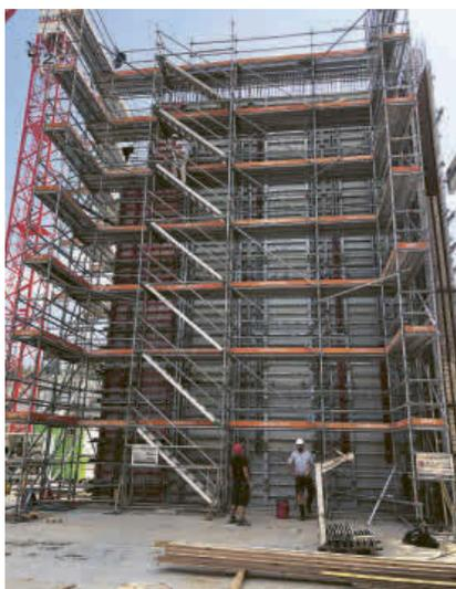
Diese Schalung ist bereit zum Auffüllen der 13.80 Meter.
