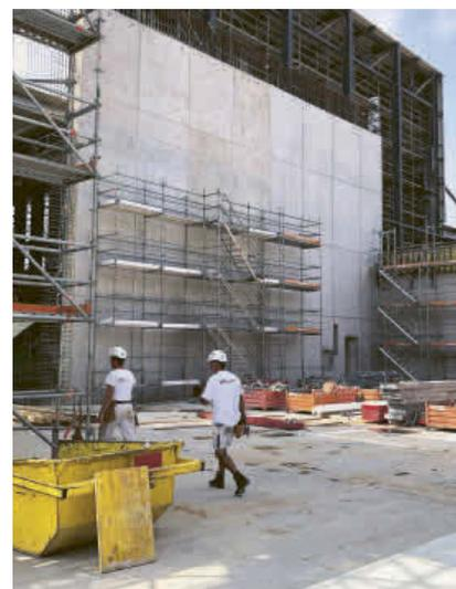
Auf diese ausgeschaltete Wand wird nun noch zweimal um 4.05 Meter geklettert, um die Endhöhe von 21.90 Metern zu erreichen.
